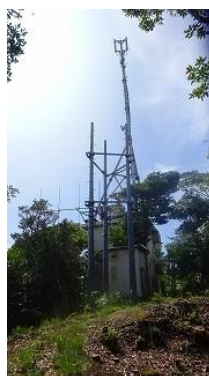
頂上手前にある鉄塔
